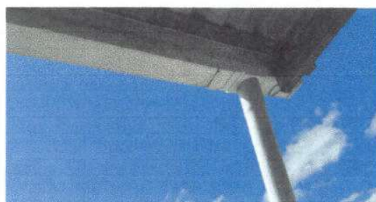
Foto 5: Instalación de canal pvc y bajada de agua en el modulo 1
