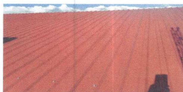
Sustitución de lámina acanalada por lámina troquelada aluzinc calibre 26 en modulo 1
