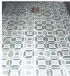
Foto 3: Sustitución de tazas y piso de torta de cemento por ceramico en servicios sanitarios
